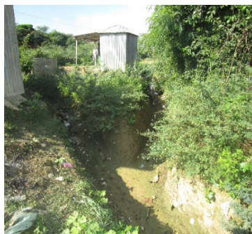
Poste-Métier vor und nach dem Wirbelsturm Matthew. Der Kanal wurde bereits zur Hälfte mit Erde aufgefüllt. Der Bauer auf dem Foto konnte vorher seinen Arm ausstrecken, um die Höhe des Kanals zu erreichen.
