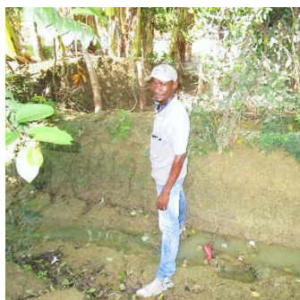
Poste-Métier vor und nach dem Wirbelsturm Matthew. Der Kanal wurde bereits zur Hälfte mit Erde aufgefüllt. Der Bauer auf dem Foto konnte vorher seinen Arm ausstrecken, um die Höhe des Kanals zu erreichen.
