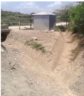
Poste-Métier vor und nach dem Wirbelsturm Matthew. Der Kanal wurde bereits zur Hälfte mit Erde aufgefüllt. Der Bauer auf dem Foto konnte vorher seinen Arm ausstrecken, um die Höhe des Kanals zu erreichen.
